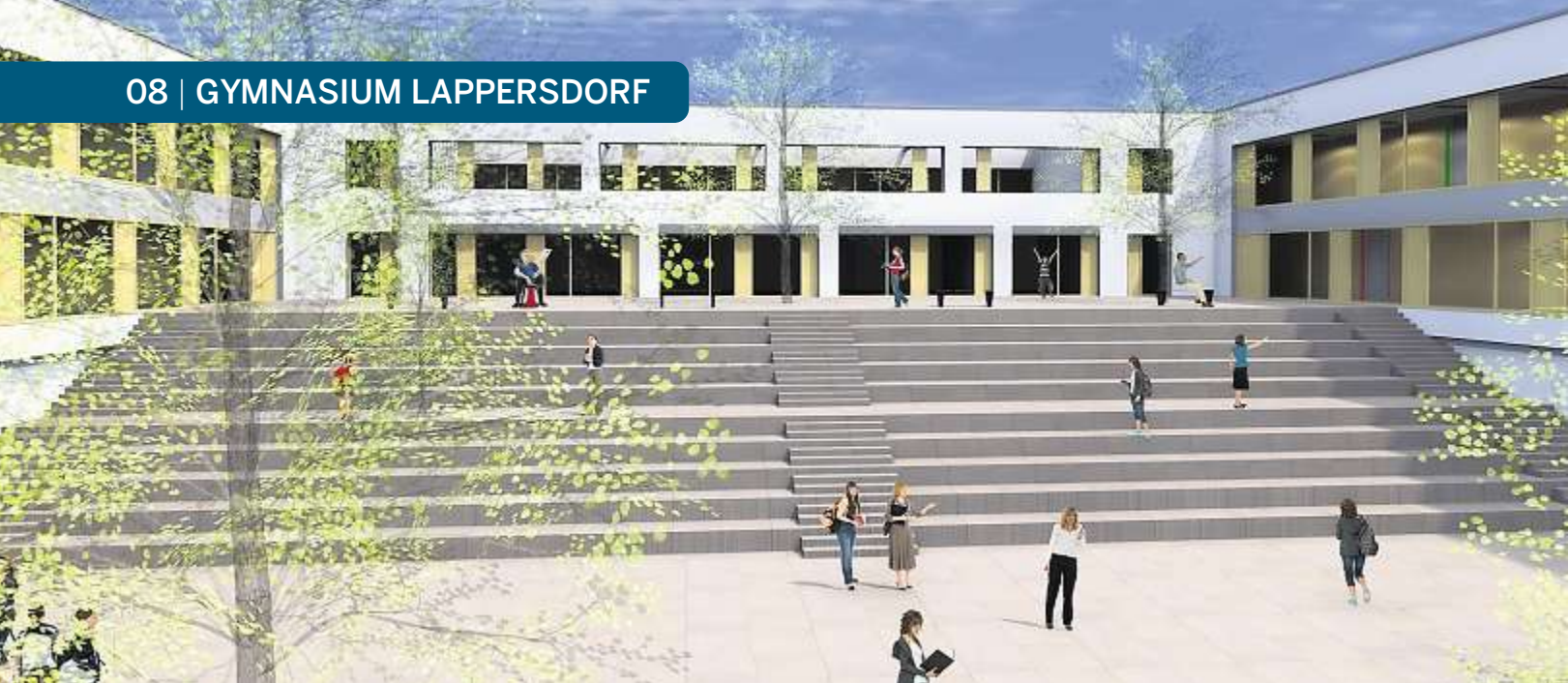
Ein Innenhof wie ein Atrium: Die Stufen laden nicht nur zum Ausruhen in den Pausen ein, sie bieten sich auch als Zuschauerränge bei Freiluftveranstaltungen an.
