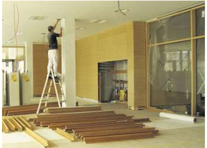
Noch während der Sommerferien wurde eifrig am Innenausbau der neuen Schule gearbeitet, wie hier in der zukünftigen Mensa.
