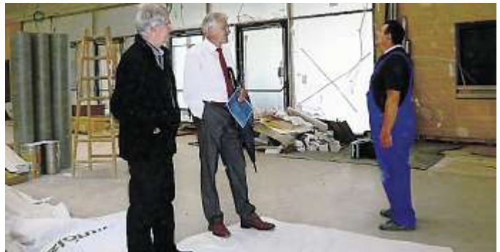
15 Monate wurde am neuen Schulgebäude „In der Pfeifing“ gearbeitet – Schulleiter Ulrich Sellner und Bürgermeister Erich Dollinger überzeugen sich vor Ort vom Fortschritt der Arbeiten. Foto: Geipel
